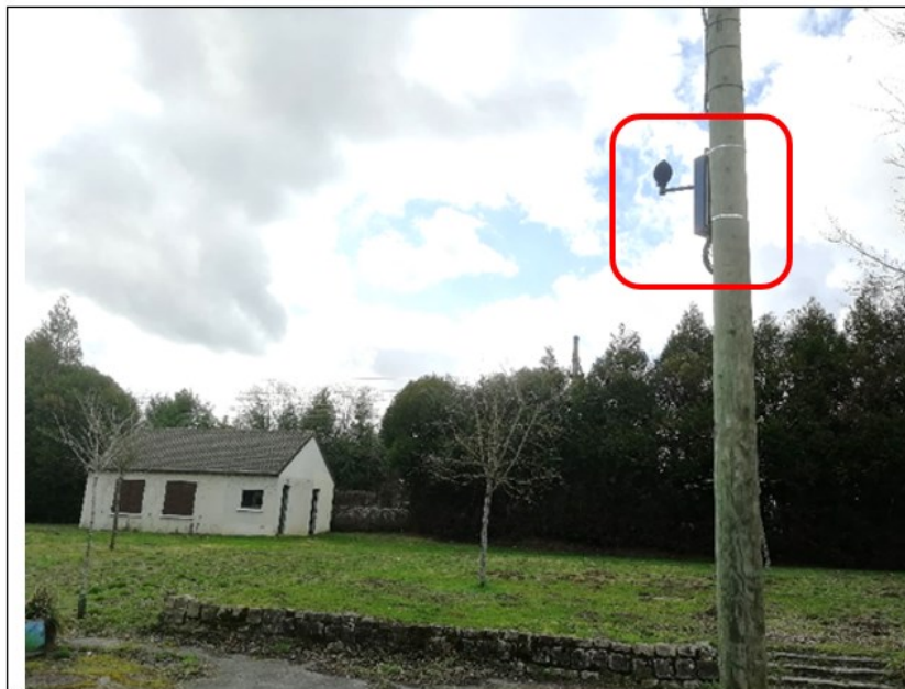
Vue de la station de mesure
