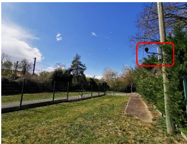
Vue de la station de mesure
