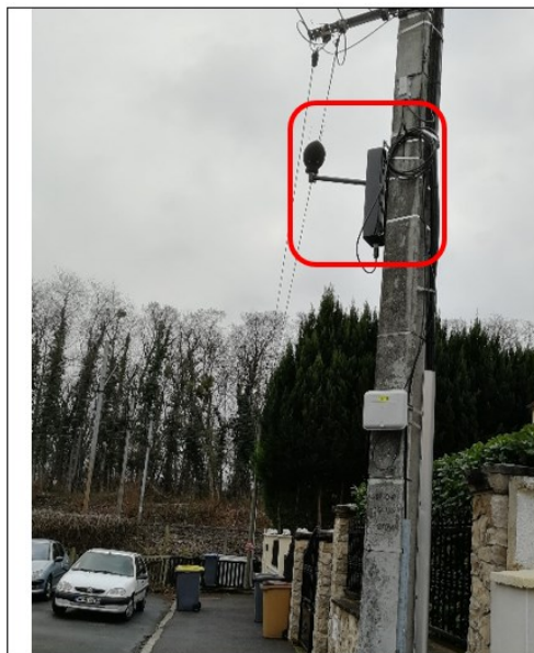
Vue de la station de mesure
